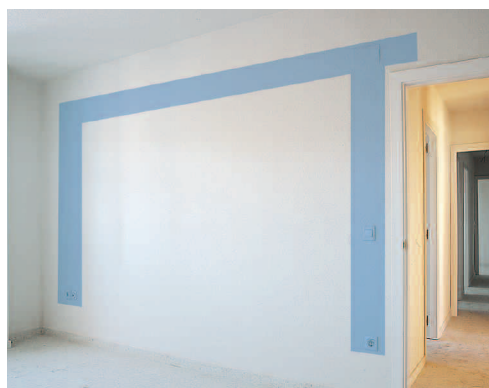
24. Bandas por donde discurren las instalaciones. Salón.
