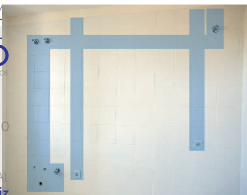
23. Bandas por donde discurren las instalaciones. Cocina.
