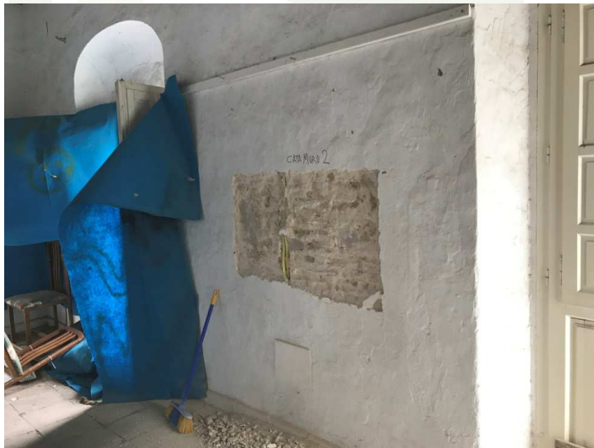
Muro de fachada, planta 1ª, se aprecian restos de piedras en matriz de mortero de cal.
