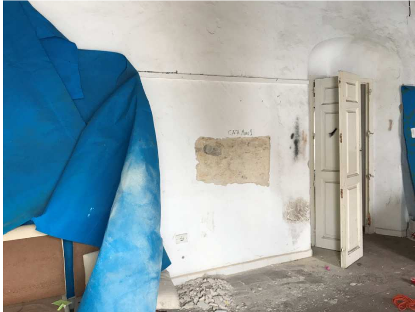
Vista general de muro interior, primera planta.
