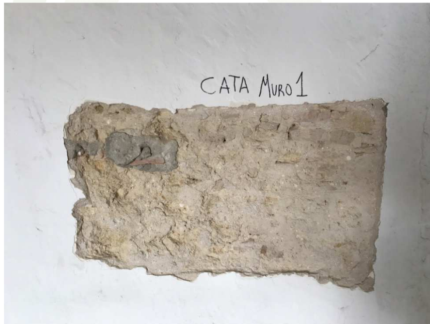
Muro interior, 1ª planta
