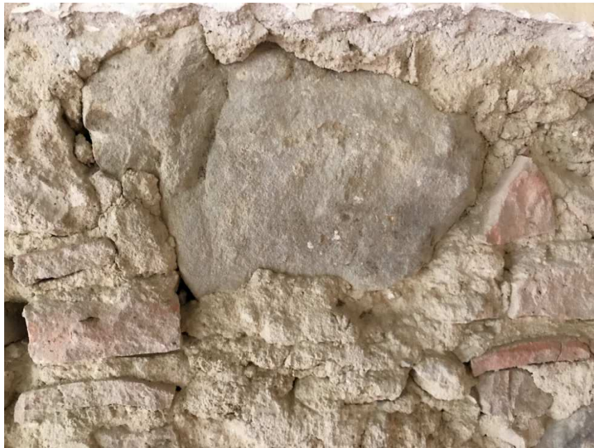
Muro de fachada, planta baja, detalle de la composición del muro.
