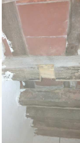
Detalle de la toma de muestra de la madera de una de las vigas.
