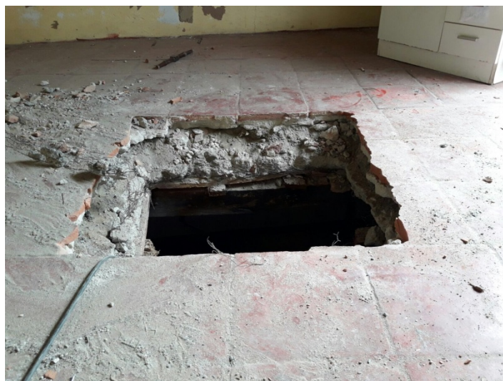
Forjado actual con 25 cm de relleno
