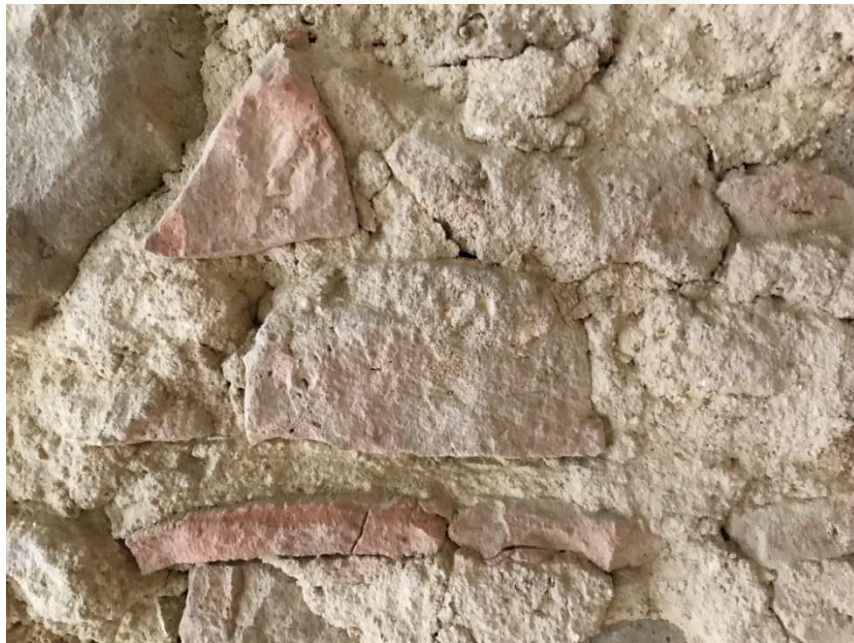
Detalle de la composición del muro, obsérvense los restos de tejas.
