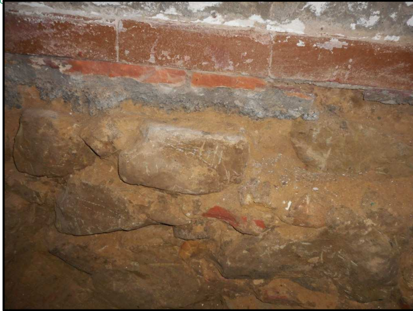
Detalle de la cimentación de la vivienda.
